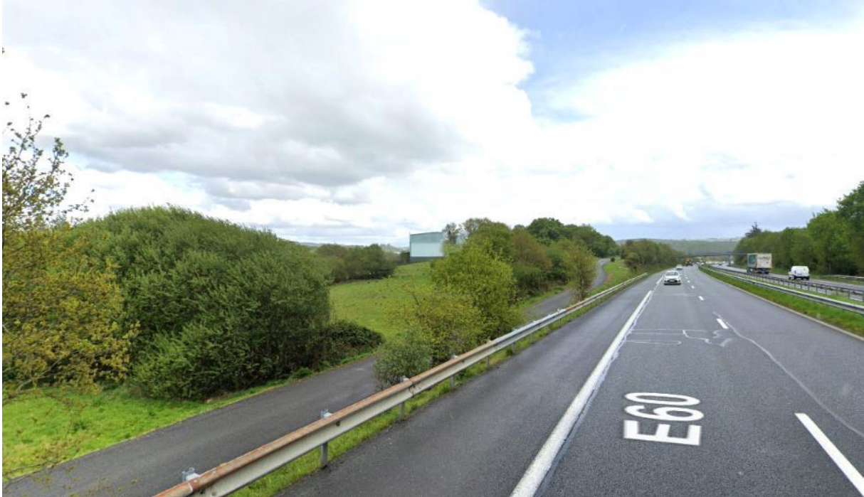
Figure 40 - Visibilité de l'installation depuis la RN 165
